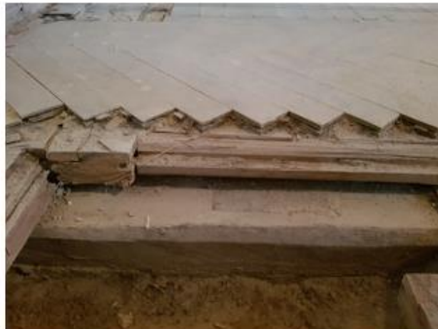
Рисунок 3.3 – Конструкция пола
