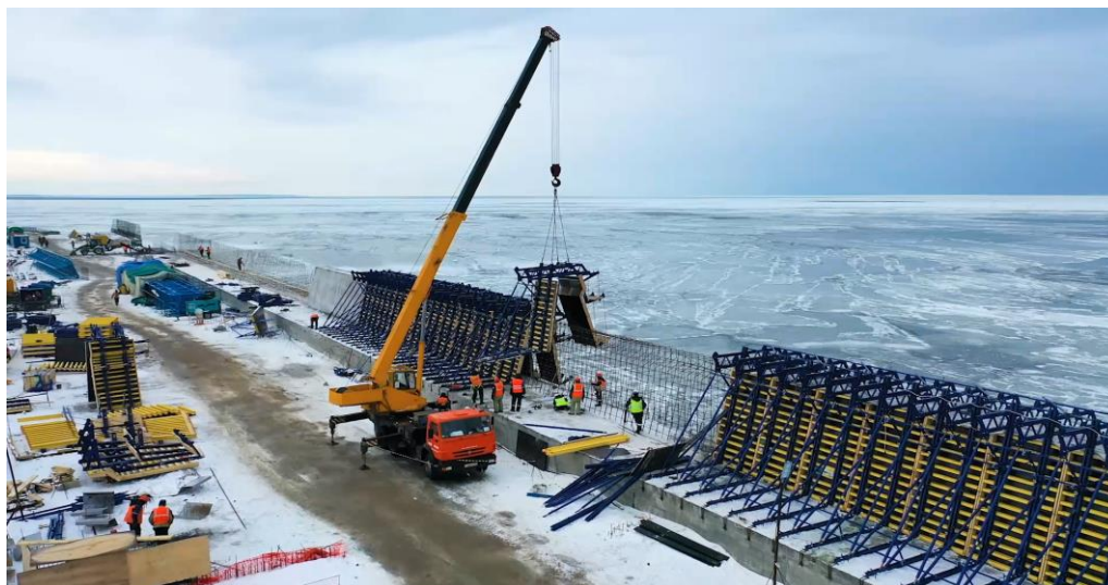
Рисунок 114 – Производство работ по возведению монолитного парапета у ПГТС газового терминала «Газпром СПГ Портовая» (Выборгский залив) [291].
