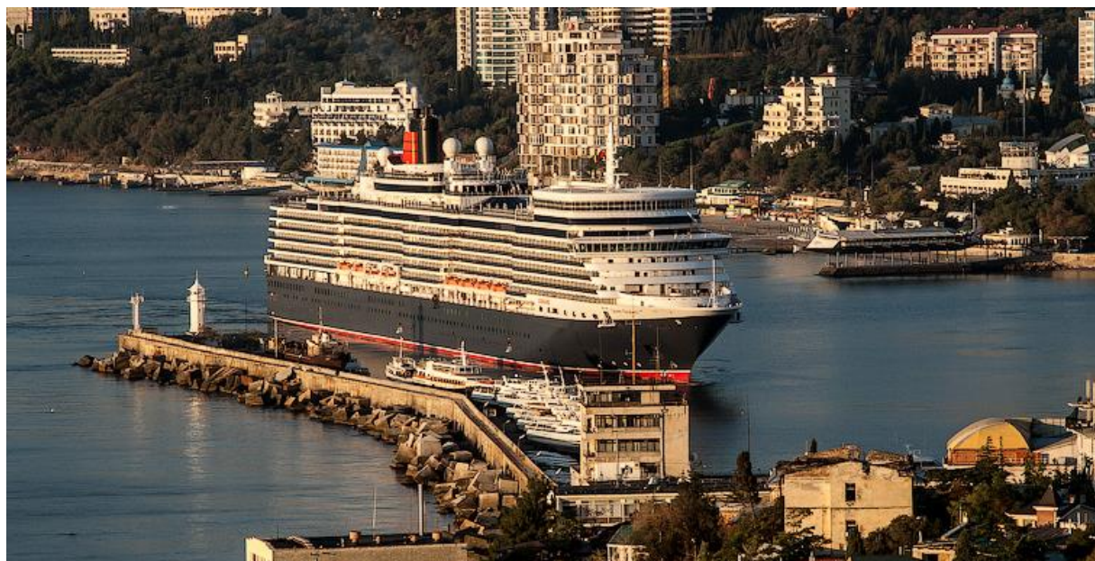
Рисунок 13 – MS Queen Elizabeth в Ялтинском порту и совмещённое оградительное и причальное ПГТС [331].
