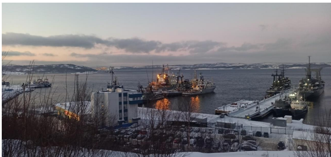
Рисунок 10 – Пример естественно огражденной акватории с пирсовой компоновкой причального фронта в Кольском заливе (фотография сделана в декабре 2022 г.).
