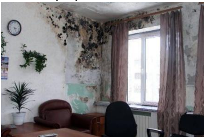
Рис.1. Биообрастание поверхностей из цементных материалов внутри жилых помещений
