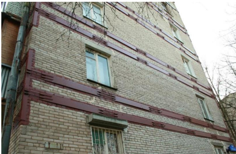
Рис.1. Установленные тяжи для стен
