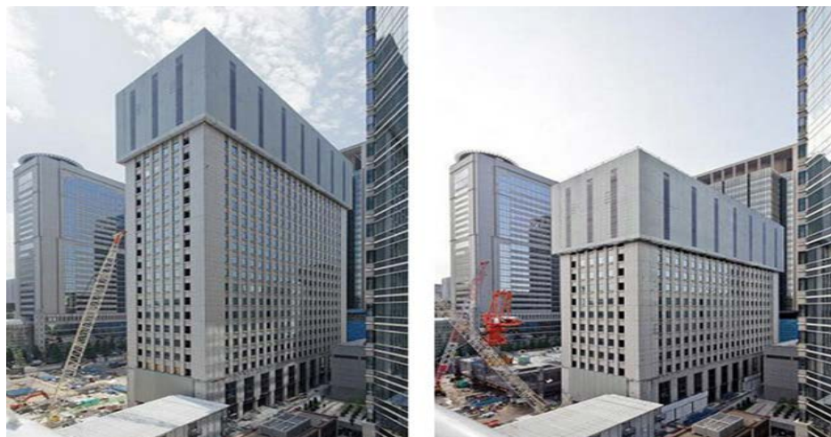
Рис. 3. Демонтаж небоскреба сверху вниз по системе Тесореп
