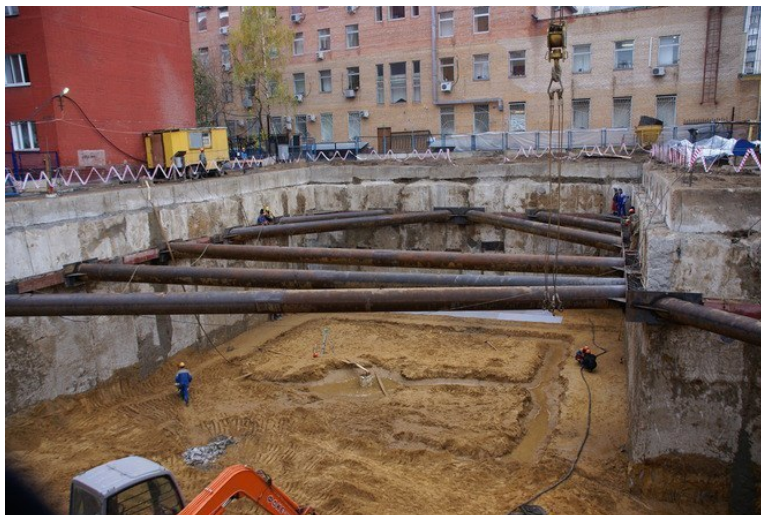
Рис.1. Пример строительной площадки со стесненными условиями производства работ
