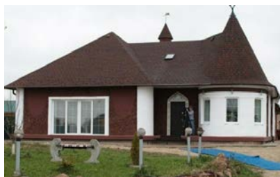
Рис. 4. Офисное задание, созданное с помощью 3D-принтера
