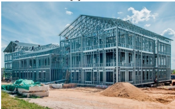
Рис.2. Общественное здания из ЛСТК. Стадия строительства
