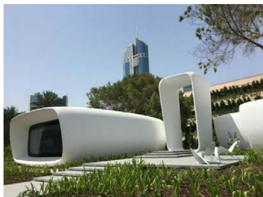
Рис. 3. Офисное здание, созданное с помощью 3D-принтера
