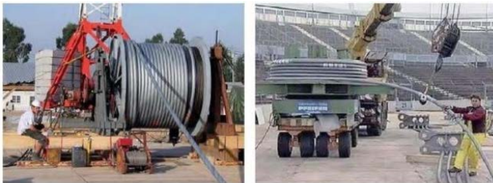
Рис.2. Предварительная раскладка вантовых канатов.
