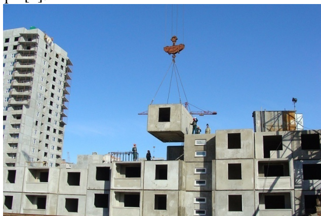
Рис. 1. Строительство многоквартирного дома из железобетонных модулей
