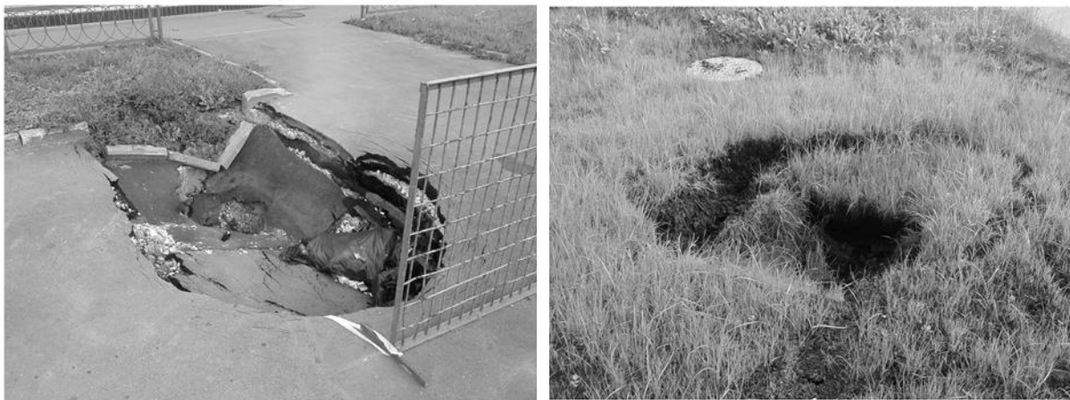
Рис. 1. Пример образования провала грунта в городе на заасфальтированной (слева) и незаасфальтированной (справа) территории.
